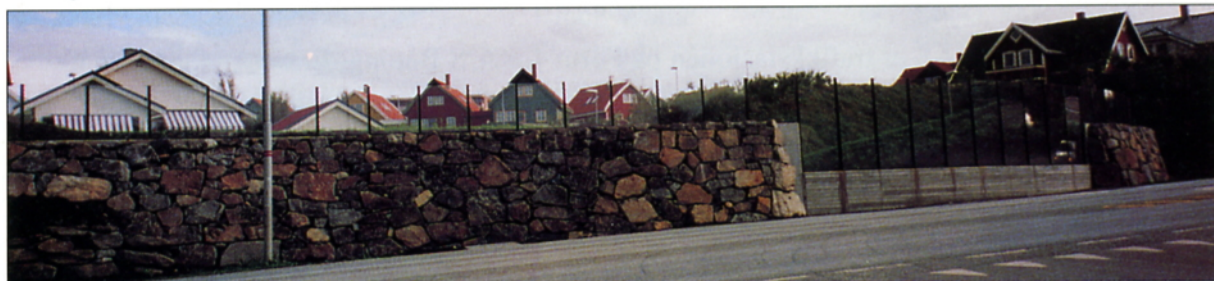
Støyskjerm Tasta, Stavanger kommune. Arbeidene er utført av Bjørn Sveinsvoll
