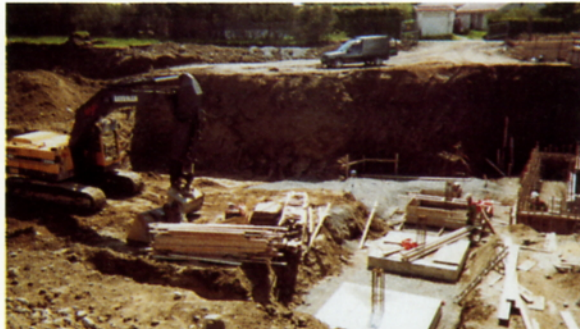
Tilbygg Hå sjukeheim
