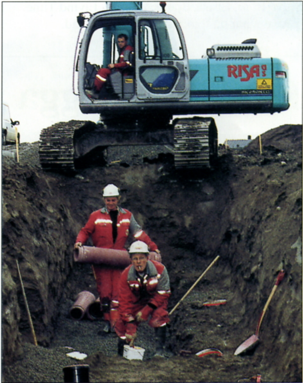
Harald Holm og Odd Magne Lode arbeider i grøfta, mens Cato Skrettingland styrer spakene i gravemaskinen
