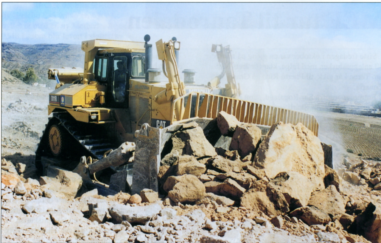
Bulldoser i aksjon
