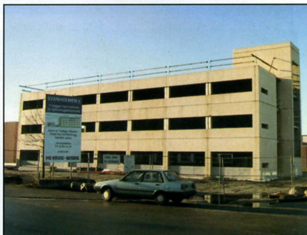
Montasje Svanholmen 7 Fylkestyrgdekontoret
