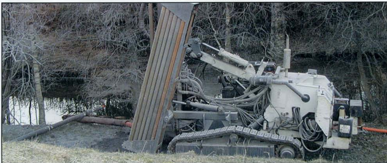
Boring av energibrønn med 185m vannspeil i Sande, Vestfold
