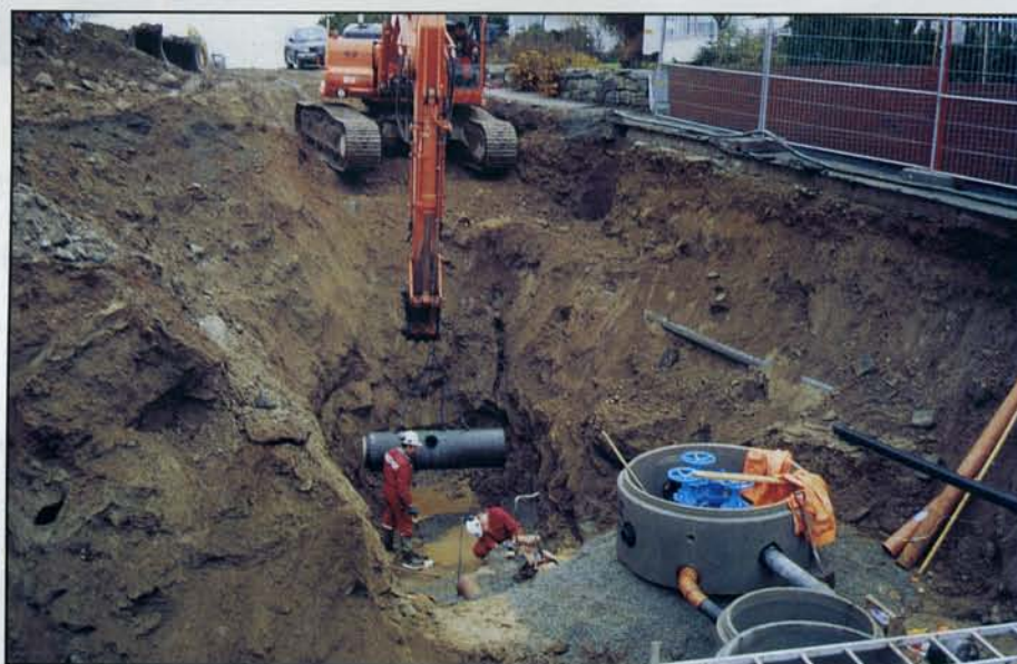
Torleif og Tron i grøfta på Brynehaugen
