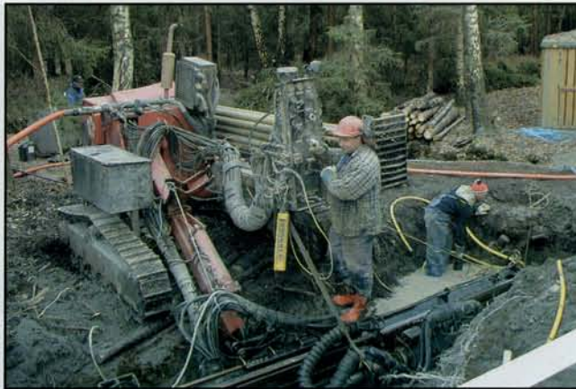
Horisontalboring for vann og kloakk på Veierland, Vestfold
