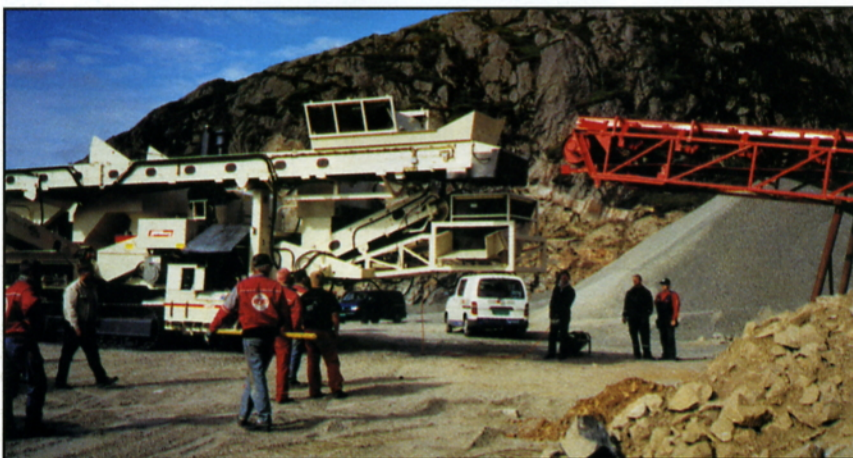
Knuseren er ferdig montert og er på vei innunder påmatingsbeltet på Moi.
