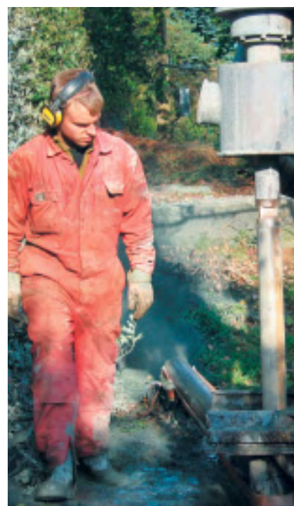
Tom Jensen i gang med boring av vannbrønn i Egersund.
