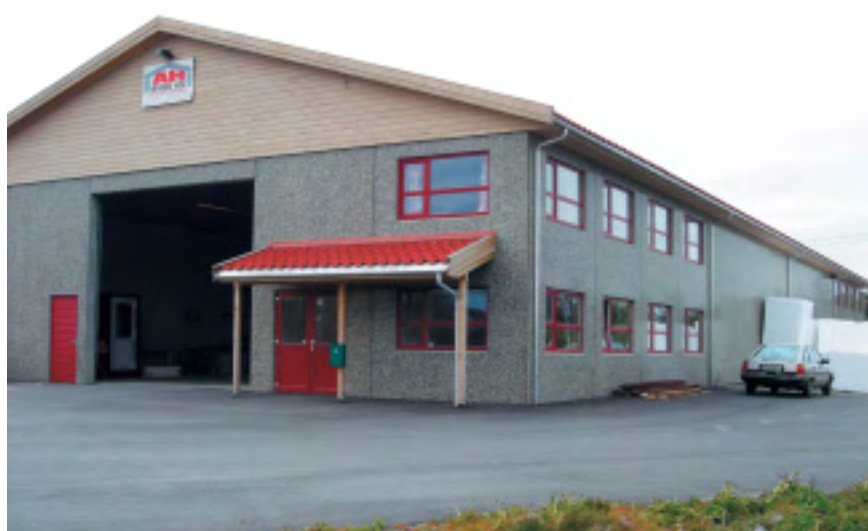
Nybygget, med slipte og polerte element fra AS Betong.
