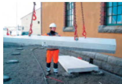
Ørjan Svihus i gang med montering av utvendig "golv"
