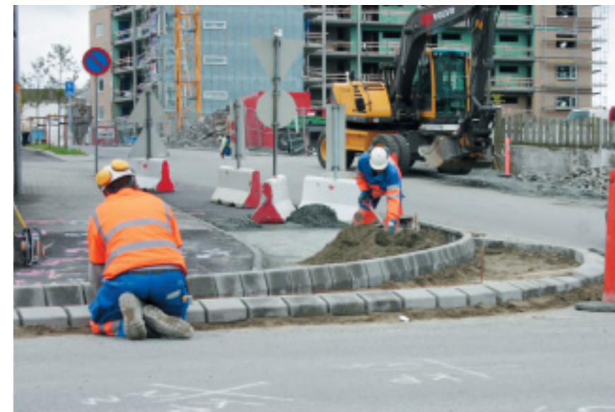
Kantsteinarbeid i Hulda Garborg veg.
