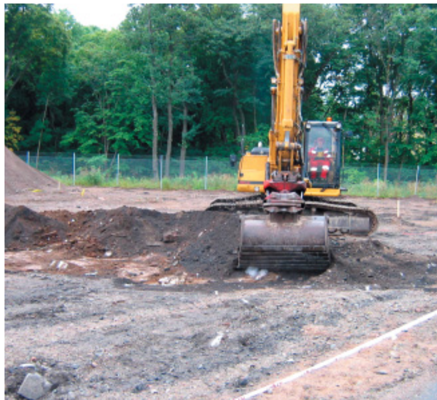
Bak spakene i en innleid Cat 322 fjerner Roar Østerhus de forurensete massene i et rutenett på 15 x 15 m.
