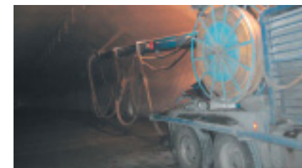
Veidekke's sprøyterigg i arbeid.
