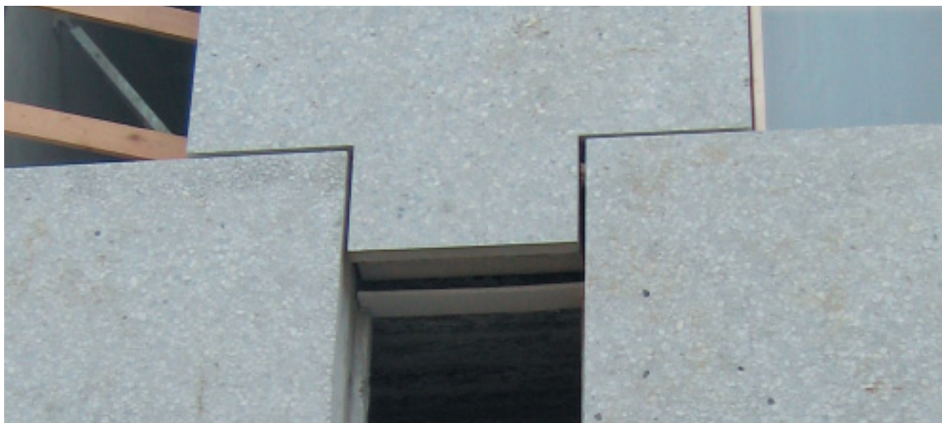
Overganger mellom elementene
