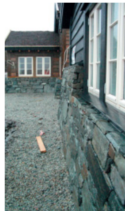
Natursteinsmur i Sirdalen.
