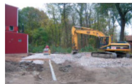
Etter at de forurensete massene var fjernet ble nye og rene masser tatt inn. Overflaten ble så justert og asfaltert.
