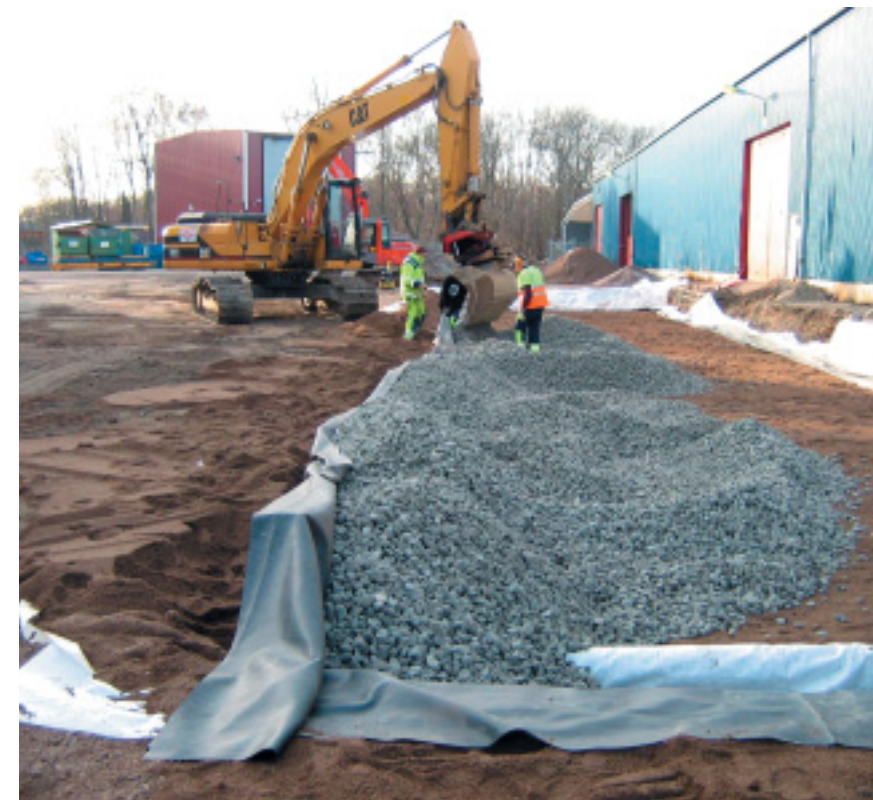
Et prosjekt for test av Hasopor som lettffylling ble gjort i et område med ekstreme belastninger fra havnens trucker.
