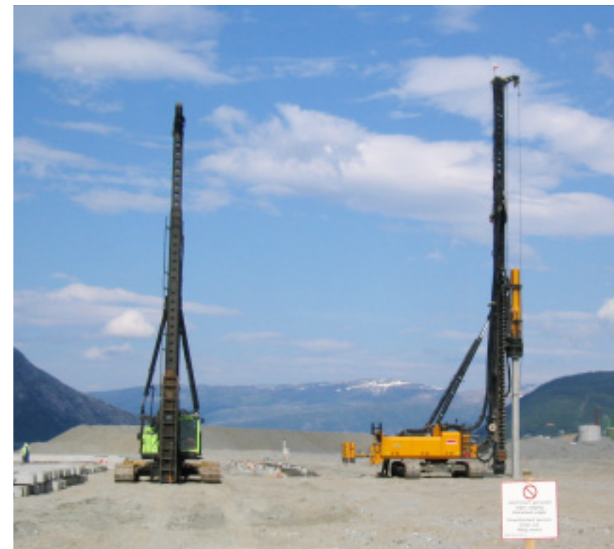
Pelemaskiner fra byggeplass i Mosjøen.
