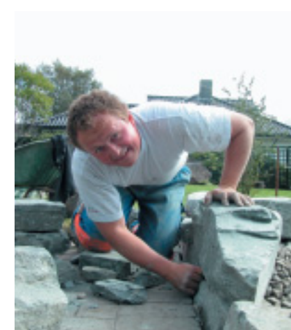
Begynnelsen på natursteinsmur.
