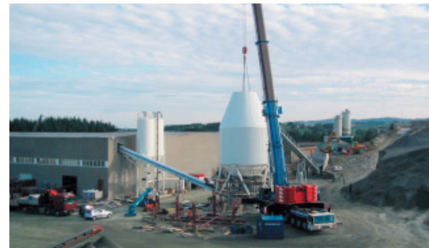
Heising av tilslagsilo.
