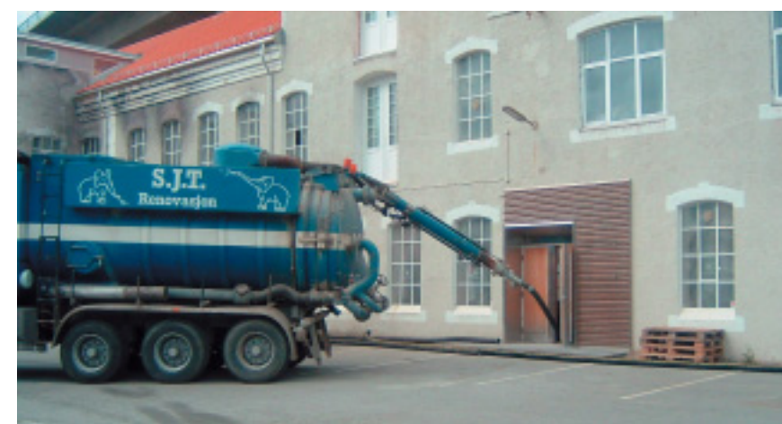
Senking av kjeller i Stavanger.
