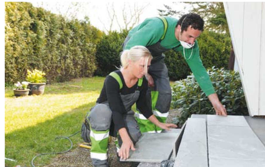
SKIFER: Dejan Vorkapic og Heidi Erga skal legge skifer på en trapp. Før skiferen kan limes på, må malingen slipes av med diamantsliper.
