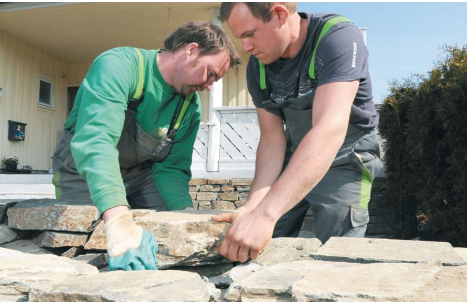
NATURSTEIN: Kunder i privatmarkedet benytter mye naturstein. Formann Tomas Aase og anleggsgartner Tim Walter er i sluttfasen av en mur.
