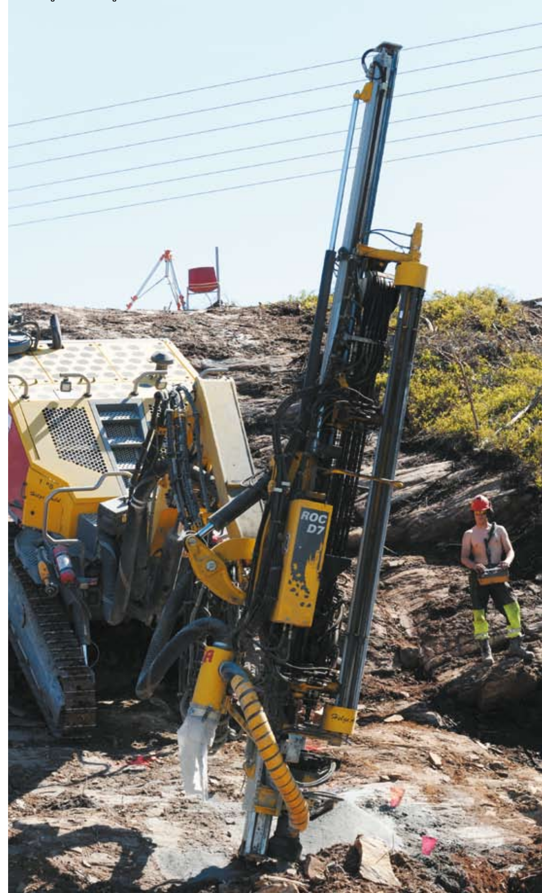
BRATT: Det er enorme steinmasser som må vike når den nye traseen til E 18 blir til. Borer Helge Arild Kindervåg liker seg i bratt terreng.
