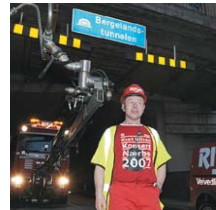
NATTARBEID: Ivar Rødland er sjåfør av vogntoget som spyle rent bak kabelbanen i taket av tunnelene.
