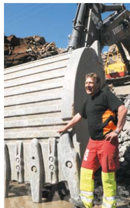
70-TONNER: Oddvar Slettebø har gravd ut all masse som Risa AS har sprenget ut fra den nye E 18 mellom Kristiansand og Grimstad. Gravemaskinen er en Volvo på 70 tonn med en fem kubikk stor skuffel foran.
