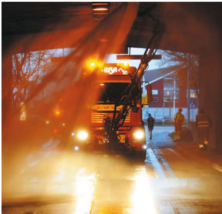
VASK AV KABELBANER: For å spyle rent bak kabelbanen i taket av tunnelen går det med 1.000 liter vann i minuttet. Her er doningen i sving i Bergelandstunnelen.
