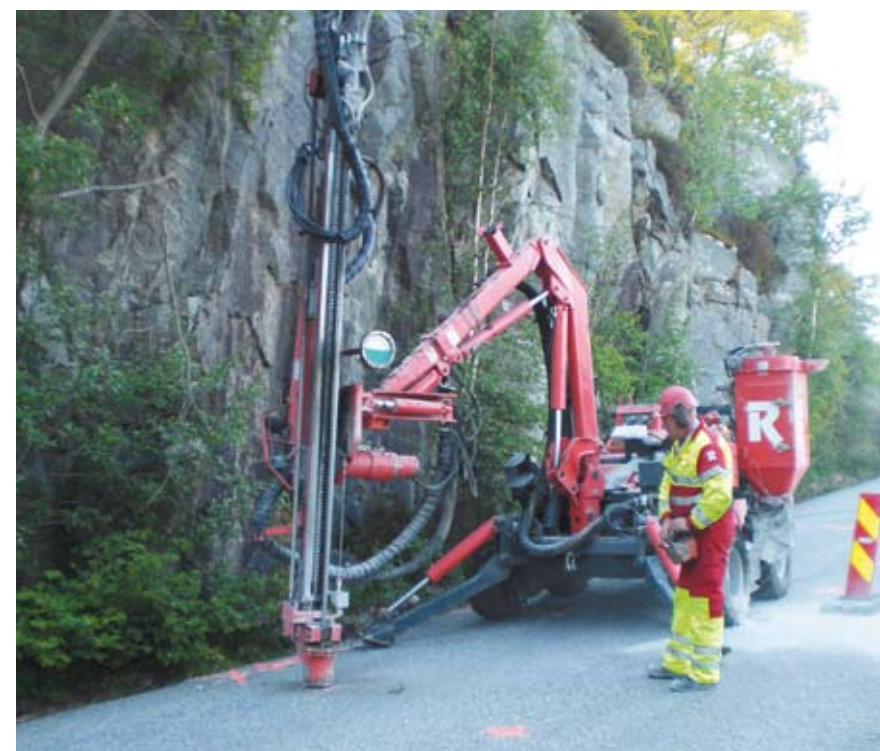
GRUNNUNDERSØKELSER: Nei, Risa Rock har ikke tatt feil av veien og tunnelen. Her er det grunnundersøkelser som blir gjort før oppstart.
