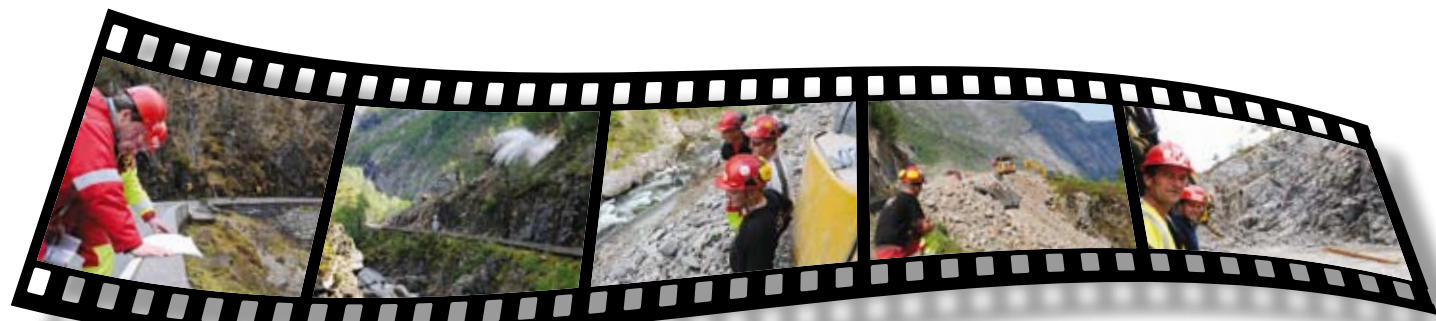
TILBAKEBLIKK: Arbeidet med de to etappene av riksvei 45 startet opp i mars 2008. Anleggsleder for Risa AS har vært Karl Riska, mens Kato Skrettingland har vært formann.
