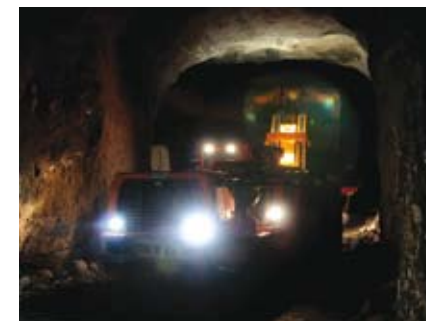
LASTEMASKIN: Lastemaskinen og boreriggen som blir brukt ved Jøssang kraftverk må være lav for å komme inn i tilløpstunnelen, som er 18 m 2 i tverrsnitt.
