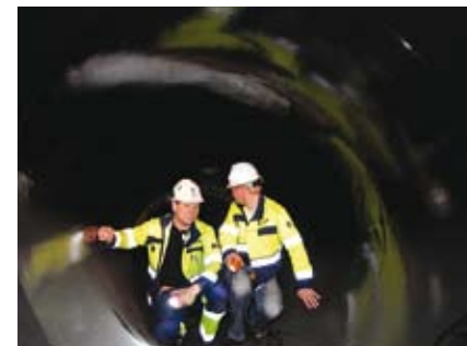
SUGERØR: Sugerøret som skal frakte vannet ut i avløpstunnelen utvider seg og fungerer dermed som en flyvinge.
