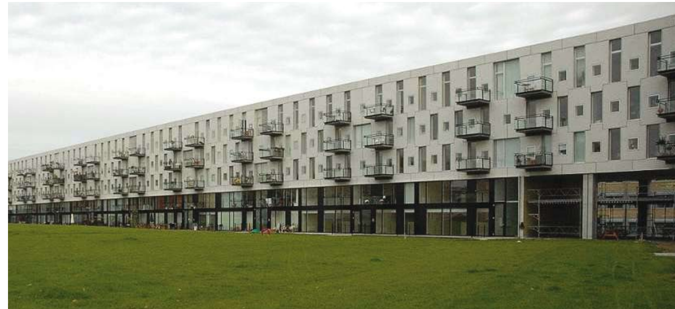
150 biler leverte 1500 slippte betongelementer i hvit marmor. Det dekker til sammen 7000 m2.
