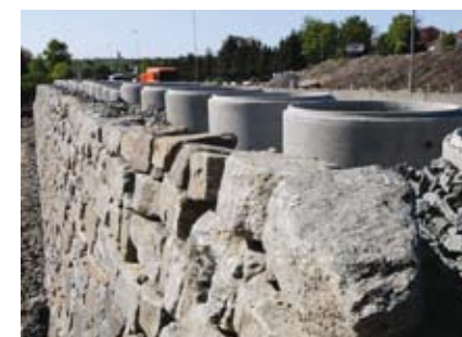
NATURSTEINMUR: En type inngrep som ikke alltid blir like synlig fra veien, men som er en viktig del av estetikken i prosjektet, er 3.000 kvadratmeter med natursteinmur langs enkelte punkter av traseen.
