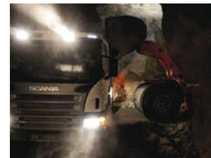
TUNNELDRIFT: Metoden med å bruke lave maskiner og utfraktning av steinmasser på lastebiler har vist seg å fungere veldig bra.
