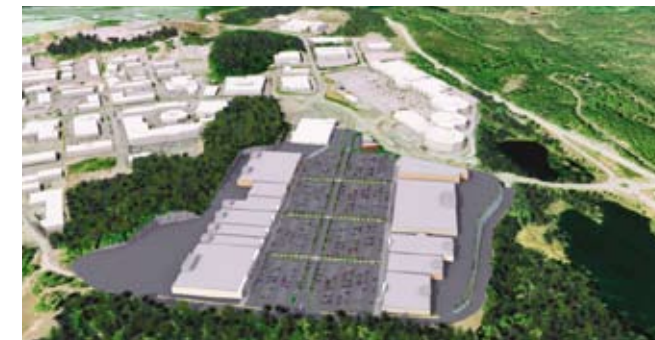
Retailparken (Avenyen): Et nytt butikkområde i Sørlandsparken øst for Kristiansand. Nor Element har i løpet av 2008 levert og/eller montert betongelementer til i alt 9 av 11 bygg, herav komplette råbygg i betong og delleveranser slik som f.eks fasader og hulledekker.
