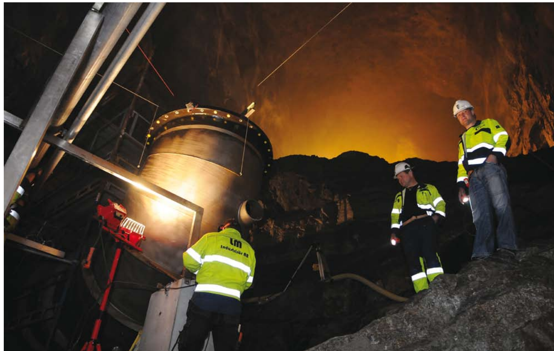
BYGGELEDELSE: De to assisterende byggelederne i Lyse Infra, Kjetil Vika (t.v.) og Einar Skarveland, inspisierer monteringen av røret som skal suge vannet ut av kraftstasjonen og inn i avløpstunnelen.
