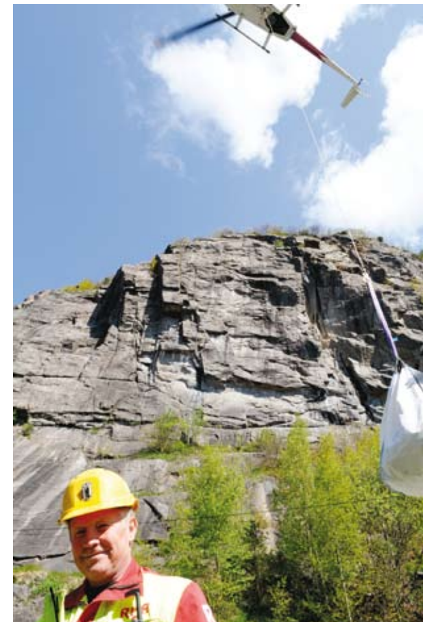
HELIKOPTERLIFT: Roar Bakken og Risa AS trengte helikopter både til befaring og transportoppdrag under oppdraget med å gjøre fjellet langs E 39 utenfor Mandal mindre rasfarlig.
