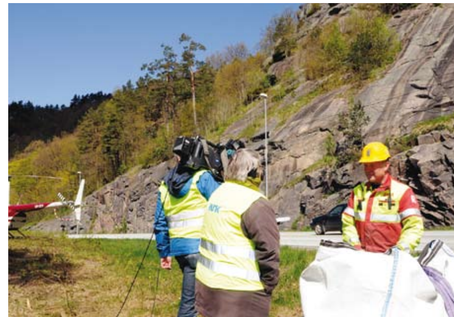
SPEKTAKULÆRT: Mannskapene fra Risa AS ble intervjuet av blant andre NRK Sørlandet under arbeidet med å sikre Sjekkefjellet.
