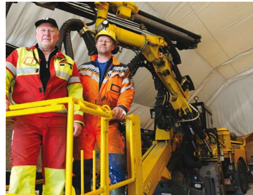
SLITTER NY: Verksmester Magnar Breimoen (t.v.) og bas for Mesta-laget ved Jøssang kraftverk, Anders Brattland, hadde ennå ikke tatt i bruk den nye riggen da dette bildet ble tatt i midten av mars.
