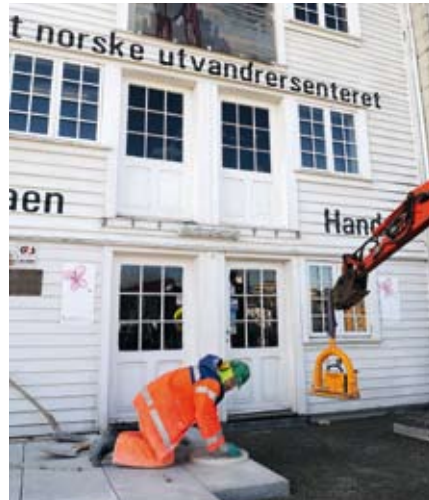
FORTAU: Steinlegger Dragoslav Buncic legger granittblokker på fortauet langs Strandkaiaen, på motsatt side av veien fra Blå Promenade.
