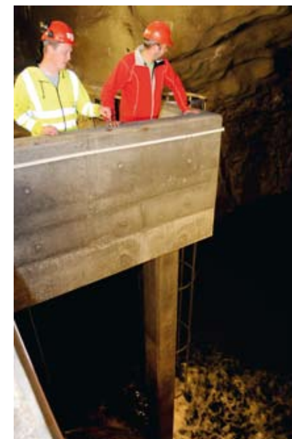
SJØVANN: Det renner inn flere millioner liter vann i døgnet i Finnfast-tunnelene. Sjøvannet blir samlet i et stort magasin i fjellet og pumpet ut igjen i sjøen.
