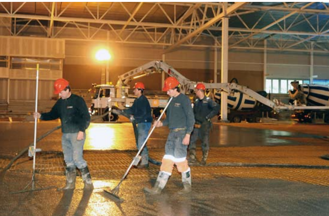
STORSTØYP: De ansatte i Egeland Gulvstøp jobbet to skift for å komme i mål med betongdekker til isflaten i midten av flerbrukshallen.
