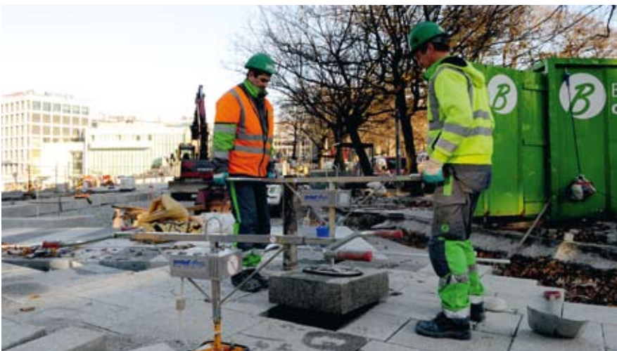
RETTER AV: Etter at steinhellene er lagt ned ved hjelp av maskin, jobber steinleggerne seg over området og retter av underlaget på millimeteren.
