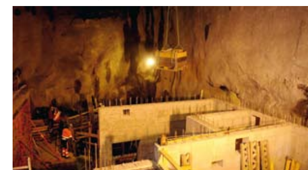
KRAFTSTASJONSTRAFOHALL: Byggekompaniet er godt i gang med å bygge opp selve kraftstasjonen der turbinene og generatorer skal stå.
