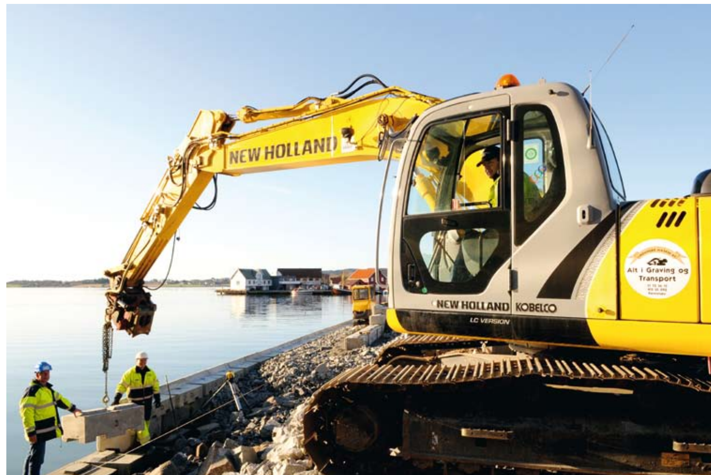
LØR I VEI: Recon-blokker fra Jærbetong går raskt å legge. Lindanger Maskin på Rennesøy foretrekker løblokker framfor naturstein i mange sammenhenger.
