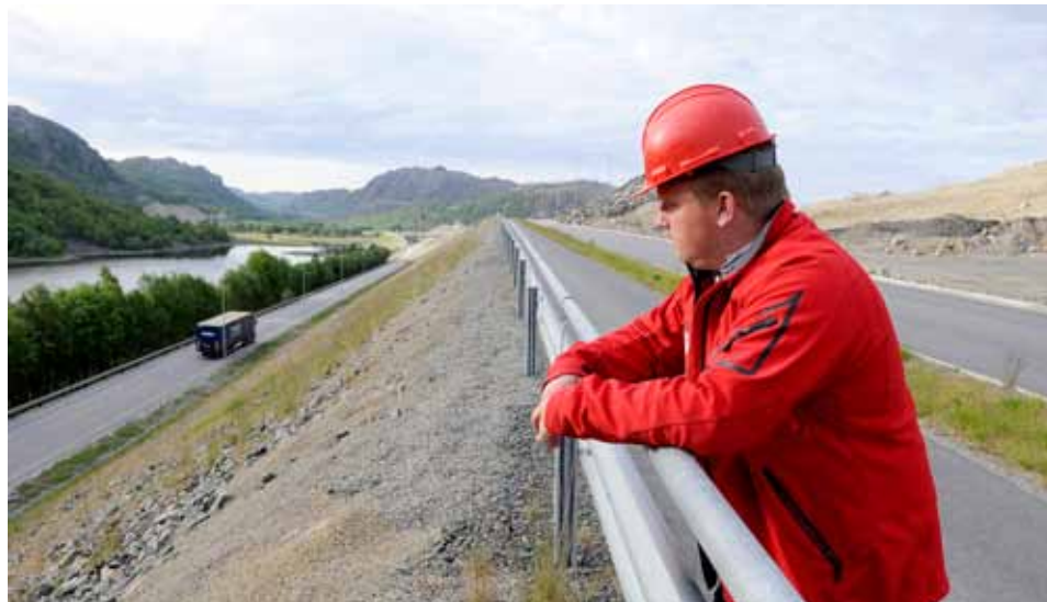
FØRST PÅ ÅSTEDET: Åsbjørn Skrettingland var anleggsleder og så på da det raste ut på Skurve.
