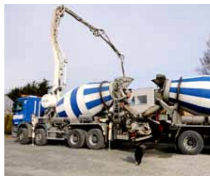
BETONG: JRG Bygg har handlet betong hos Jærbetong siden oppstarten.
