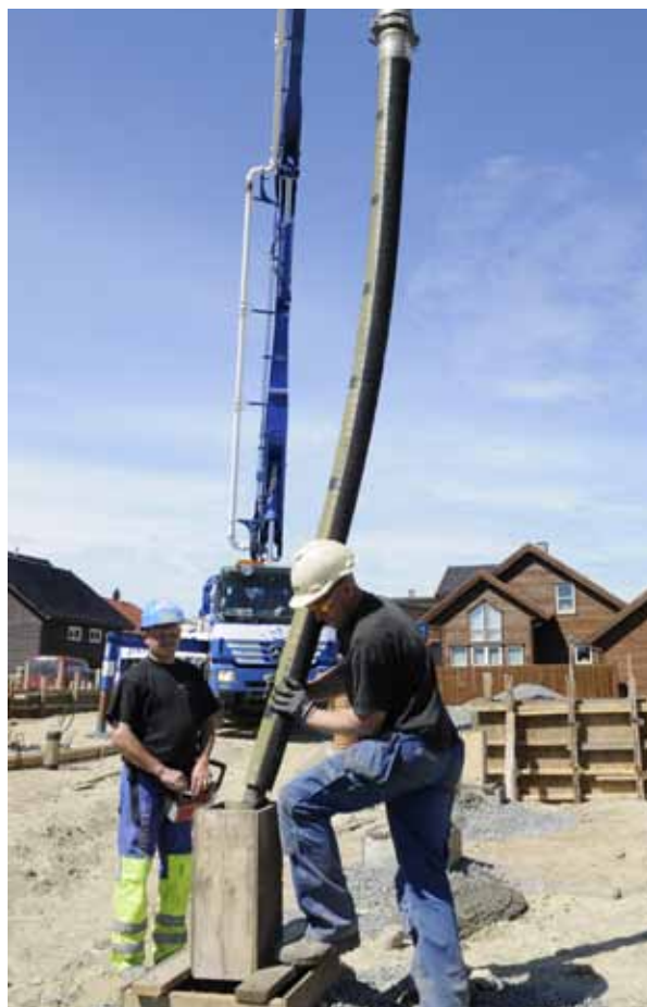
REDUCER-SLANGE: Bildet viser reducer-slange brukt under støyp av grunnmur i Motlandsmarka på Nærbø.
