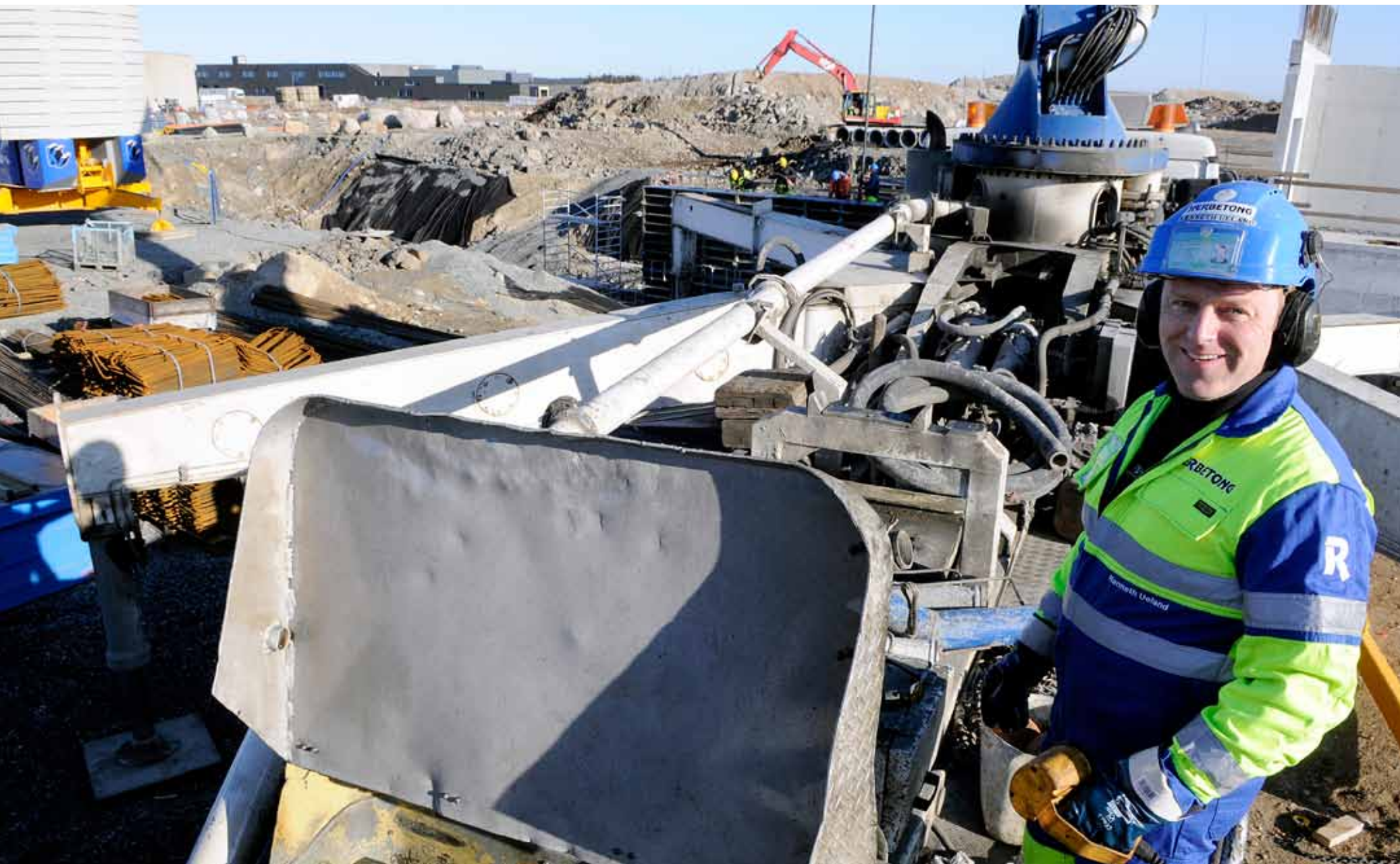
BETONGLEVERANSE: Kenneth Ueland leverer betong til rett tid og kvalitet til Kvía AS sitt prosjekt for Tine BA.
