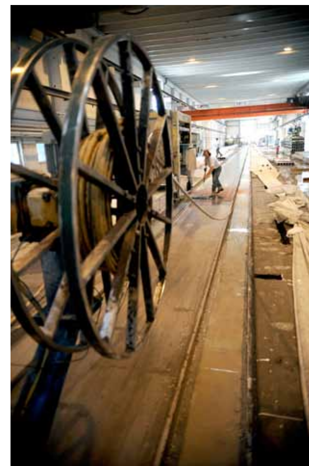
STORE DIMENSJONER: Hulldekkproduksjonen foregår i den 150 meter lange hallen på Gismøya, like utenfor Mandal sentrum.
