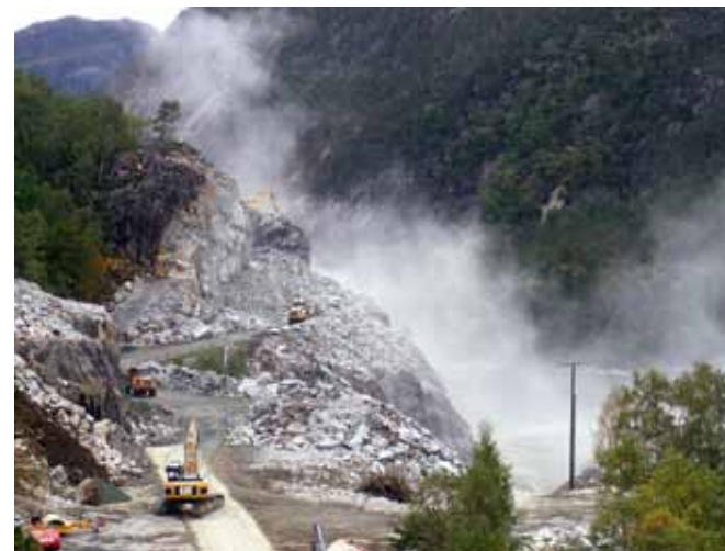
Anlegget med riksvei 13 langs Erfjord
