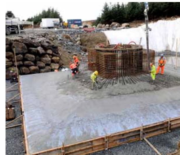
1.200 TONN: Hvert fundament for vindmøllene veier rundt 1.200 tonn. Vekten av massene som skal dekke over fundamentet er også med å forhindre at de velter.
