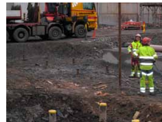
Montering stålkjerner på Hydro Herøya
