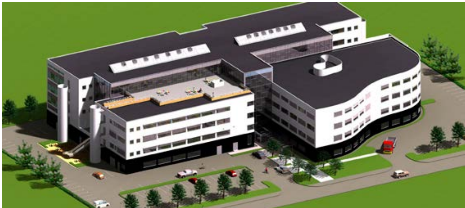
Nytt bygg for Fabricom
