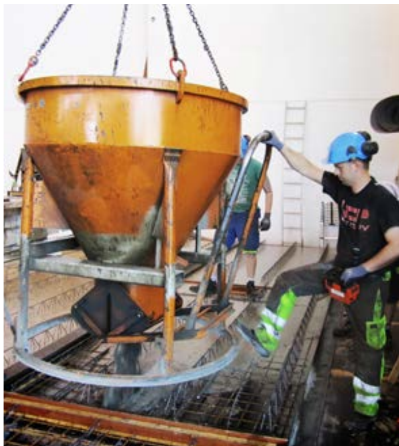
Sven Grødeland støper Plattendekke på Jærbetong
