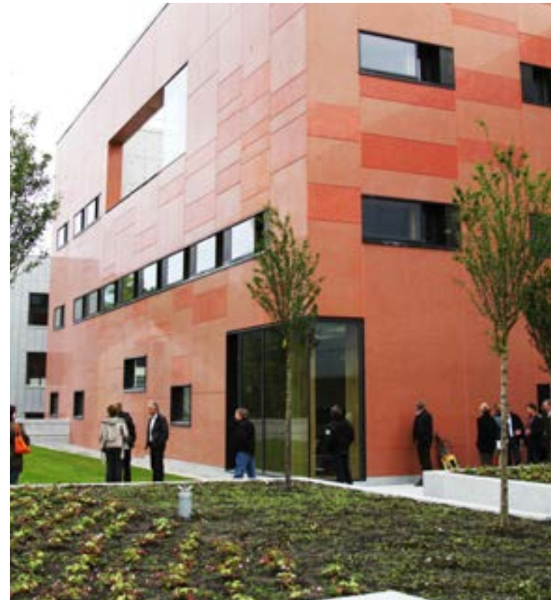
På befaring: AS Betong var på befaring i konserthuset sammen med elementforeningen
