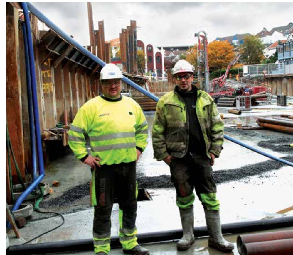
Det skal totalt bores og monteres 800 meter med peler, det nye Scandic-hotellet skal bli klart i løpet av 2013. Her formann Stian Bø og Bjarte Bratneb i byggegropa.
