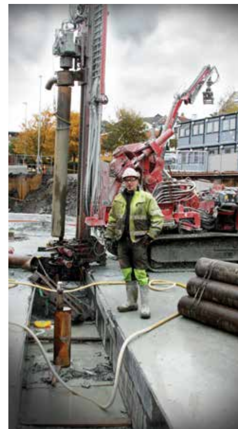
– Vi har boret opptil 30 meter ned til fjellet for spuntstagene, sier Bjarte Bratneb som borer ned foringsrørene.
