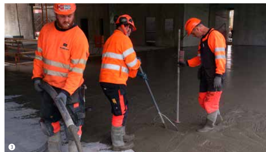
1 Kai Inge Skjæveland leverer SKB Betong til høy vegg. 2 Fasade mot jernbanen 3 Ståle Husebø og gjengen påstop på hulldekeelement
